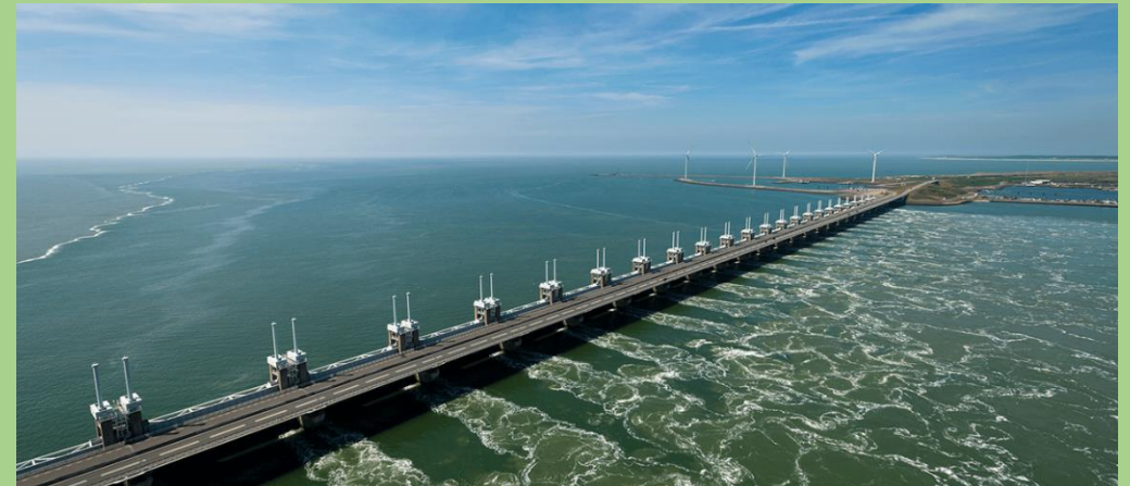
I lavori del Delta
